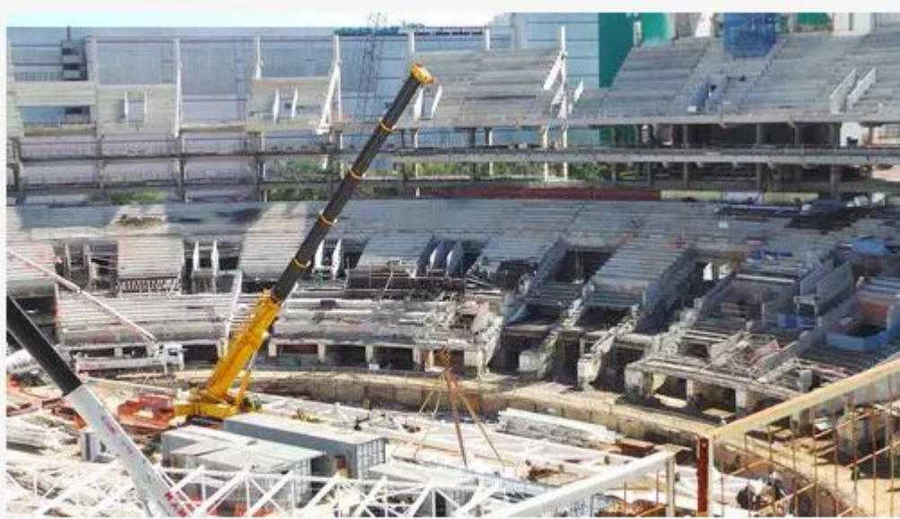
徐工起重机建设萨尔瓦多新水源竞技场
